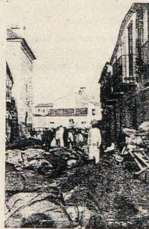
Calle de Mármoles, después de la inundación. Pueden apreciarse fácilmente los grandes daños causados por la inundación.
