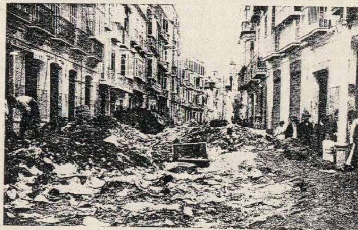
Calle de Torrijos.—Arrastres y lodo depositados. En las fachadas puede verse el nivel que alcanzó la riada.
