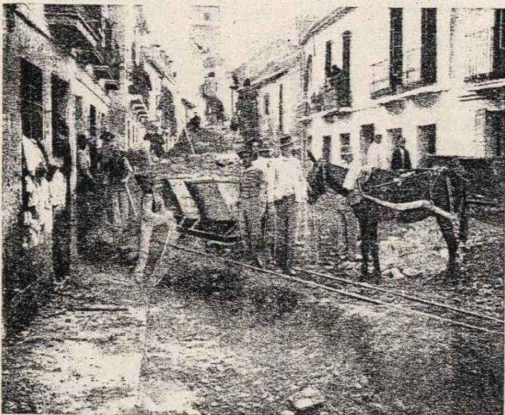
Calle de la Trinidad.—Limpieza de los arrastres depositados.
