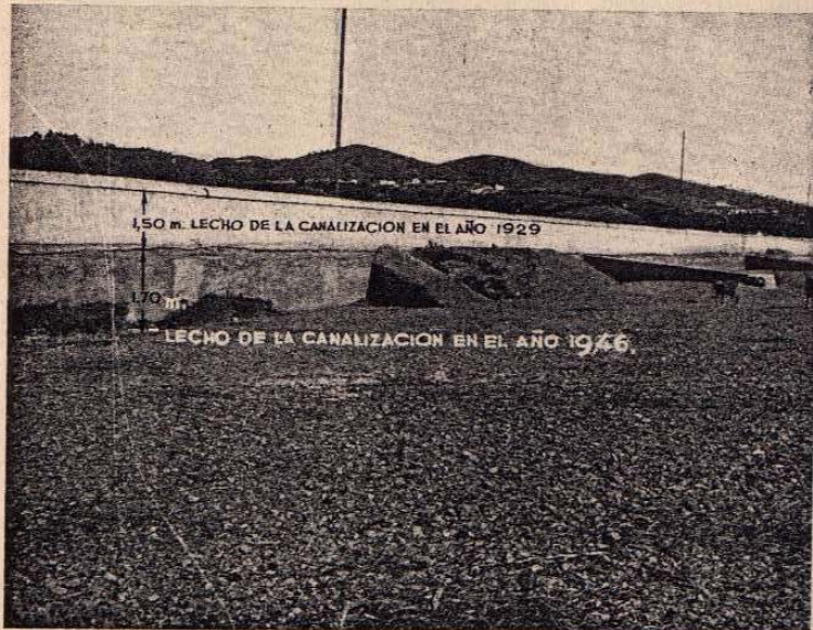
Descenso de 1,70 metros en la canalización.
